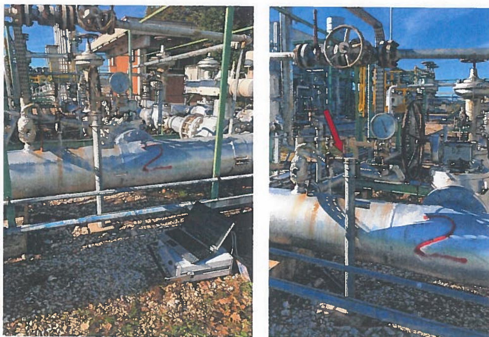
Foto 2 e 3 – \mu GC 3000 e punto di campionamento (freccia di colore rosso)
