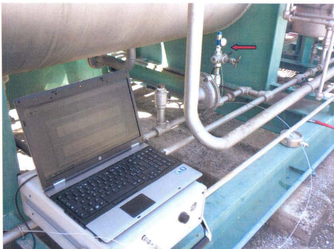
Foto 1 – Punto di campionamento (freccia di colore rosso) e Gascromatografo portatile µGC 3000 Agilent
