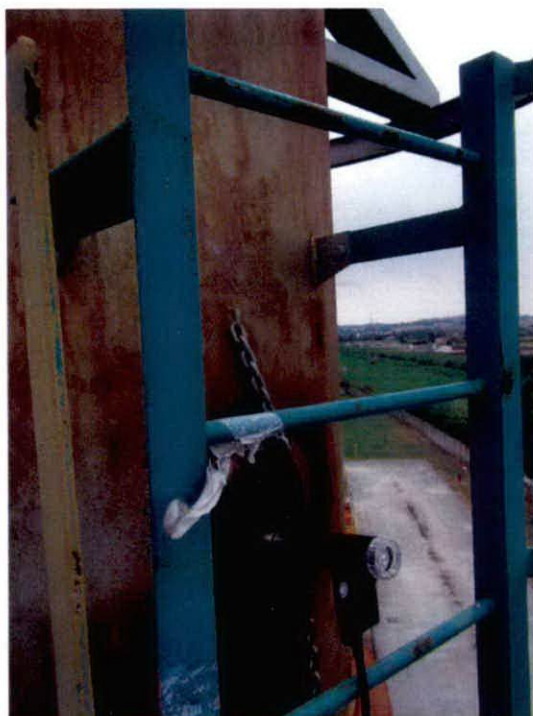
Foto 1- sonda di campionamento e punto di prelievo sul termodistruttore
