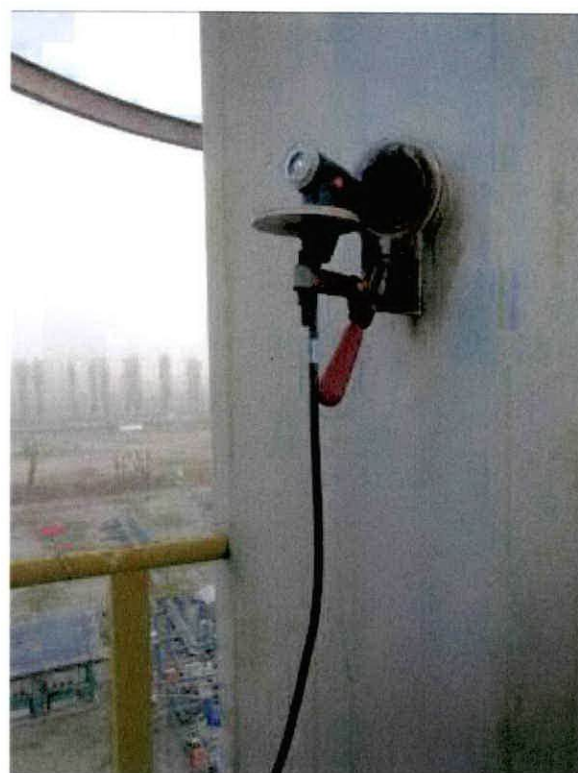
Punto di campionamento con sonda di prelievo
