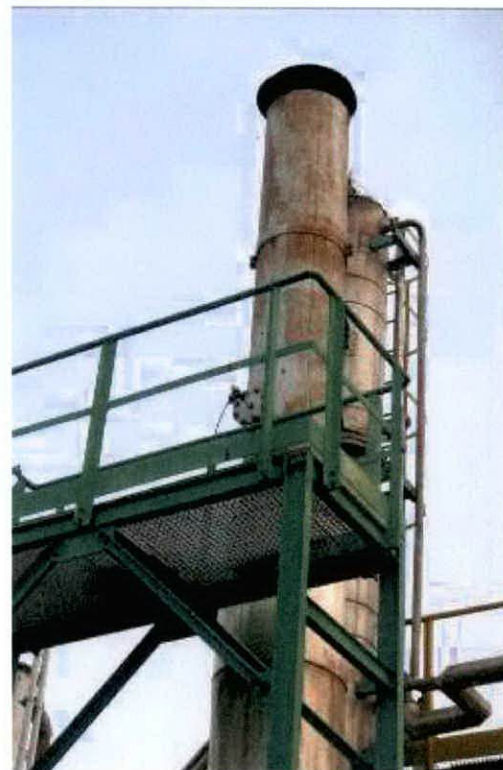
Punto di campionamento con sonda di prelievo
